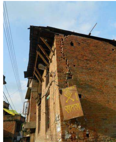
R.7.2 Low strength masonry : SMM
